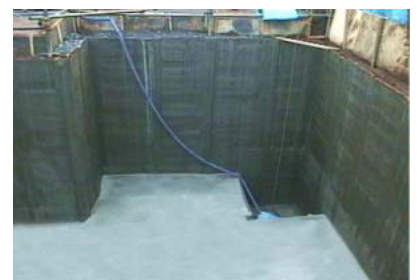
保護層施工後
